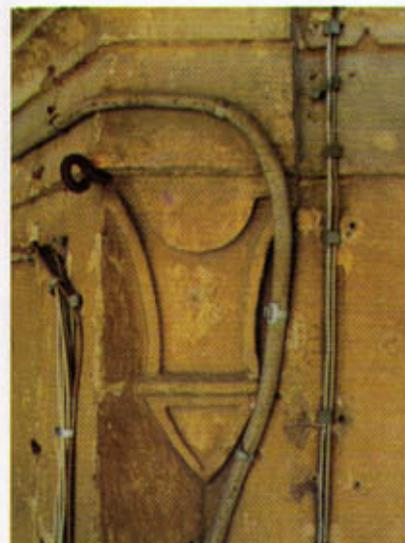
17. Particolare della gronda in beola a sbalzo, con gocciolatoio in arenaria: la stabilità del sistema è garantita da una successione di zanche nascoste nel faldato. L'intervento di manutenzione ha assicurato la capacità delle zanche di garantire il sistema
